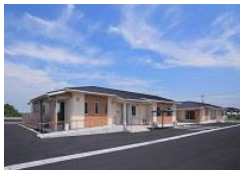
2棟並んで建設しました。9名×2棟。
