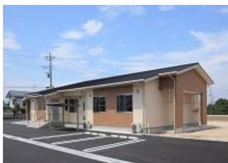
外観。木造平屋建て。1棟定員9名。
